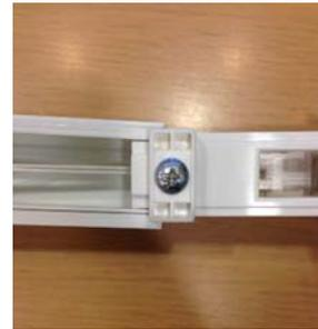
ストッパーケース下部の固定ネジを締めて固定させ、はがしていたカーテンをもとに戻します。
