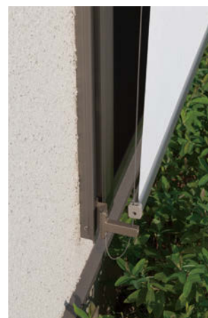
サッシ取付け時 下部アップ
